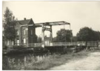
Brug 1 over de Vaart (Foto 00672_02)
