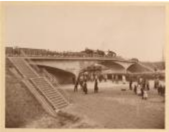
Brug over kanaal / belastingsproef (Foto 02180_01; 02180_02; 02180_03)
