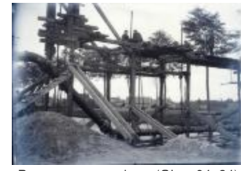
Bouwen van een brug (Glas_04_84)
