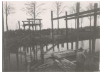
Bouwen van een kanaalbrug (Foto 05476_01; 05476_02)
