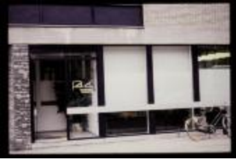
Tandtechnisch Labo (container 33_1330)
