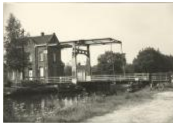
Brug 1 over de Vaart (Foto 00672_02)
