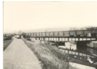
Ijzeren brug over het kanaal Dessel-Turnhout-Schoten - Opbouw (Foto 01299_01; 01299_02; 01299_03 )
