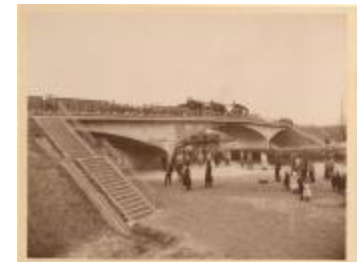
Brug over kanaal / belastingsproef (Foto 02180_01; 02180_02; 02180_03)
