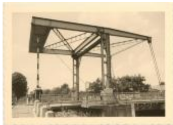
Brug 2 over het kanaal (Foto 00201_01; 00201_02)
