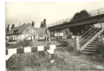
Voetgangers/fietsbrug over de Vaart (Foto 00672_01; 05222_01)
