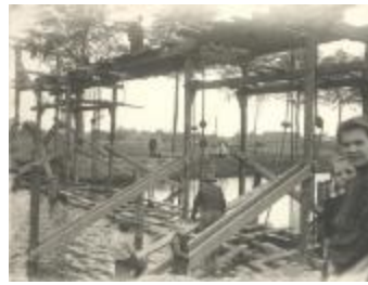
Opbouw v.d. "Ijzerenbrug" tss. Brug 1 en brug 2 ? (Foto 00377-01)
