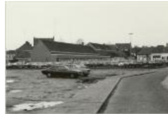
Parking Muylenberg (Foto 07036-10)
