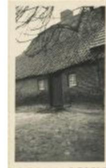
Hoeve "De Diepe" / woonhuis Klein Peerke / interieur + exterieur (foto 03956_01 t.e.m. 03956_04)
