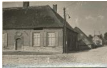
's Hertogenhoeve en schuur (Foto 01633-03 en 07)
