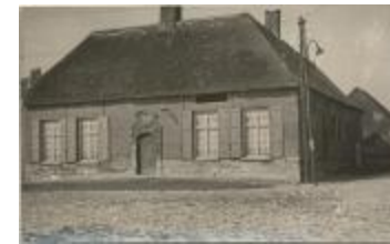
's Hertogenhoeve en schuur (Foto 01633-06 en 08)
