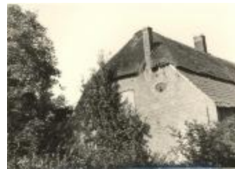
's Hertogenhoeve en schuur (Foto 01633-04 en 05)
