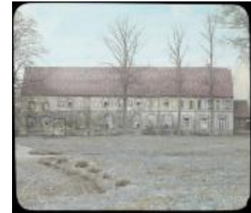
Corsendonck- gebouwen (oude vensters) (Glas0134)
