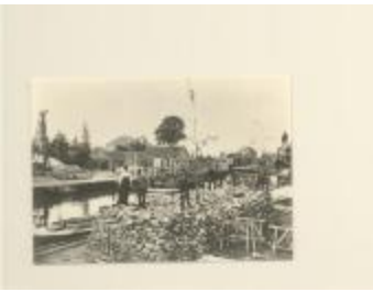
Opbouw "IJzeren brug" (spoorwegbrug) over het kanaal (03800_01 en 03800_02)
