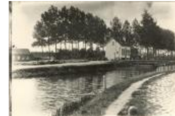
Brug 1 over het kanaal (Foto 01507-01)
