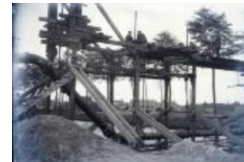
Bouwen van een brug (Glas_04_84)
