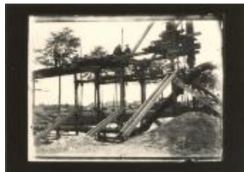
Brug leggen over het kanaal (Foto 03241_01 t.e.m. 03241_03)
