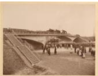
Brug over kanaal / belastingsproef (Foto 02180_01; 02180_02; 02180_03)
