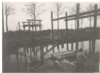
Bouwen van een kanaalbrug (Foto 05476_01; 05476_02)
