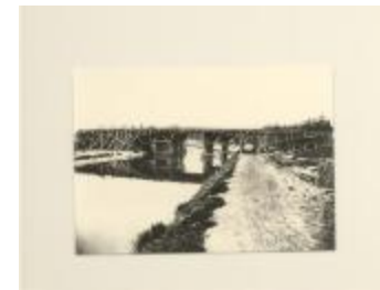
Bouw van de brug over kanaal (foto 03793_01 en 03793_02)
