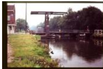
Brug I (Dia container 1_5)
