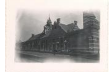
Station / Opbouw (Foto 00710-01 en 02)
