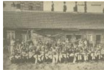
Kantschool in de Tien Geboden (Apostoliekenschool) (Foto 04837_01)
