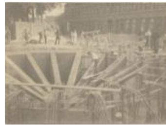
Watertoren / Opbouw - Fundamenten (Foto 00711_01)
