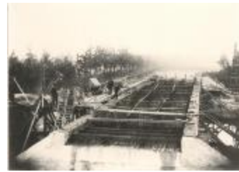
Leggen van een brug over een kanaal (foto 01396-01)
