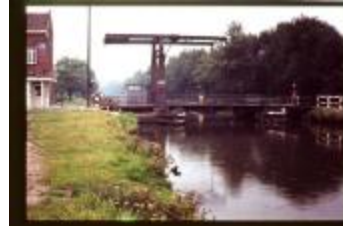
Brug I (Dia container 1_5)
