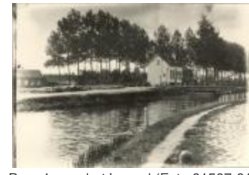
Brug 1 over het kanaal (Foto 01507-01)
