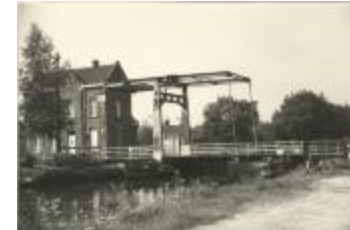
Brug 1 over de Vaart (Foto 00672_02)
