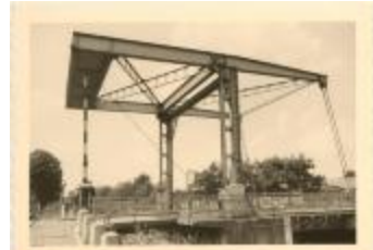
Brug 2 over het kanaal (Foto 00201_01; 00201_02)
