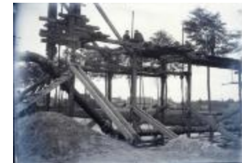
Bouwen van een brug (Glas_04_84)
