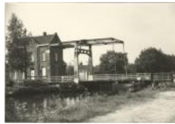
Brug 1 over de Vaart (Foto 00672_02)
