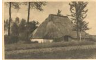
Oude Schuur (Sto dak) nabij de watermolen (Foto 00430-01 en 02 en 03)
