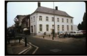
Het huis Maelsloth in de Patersstraat te Turnhout ter hoogte van het Patersplein (container 45_658)
