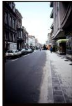
Het huis Maelsloth in de Patersstraat te Turnhout ter hoogte van het Patersplein (container 45_655)
