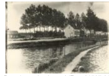
Brug 1 over het kanaal (Foto 01507-01)
