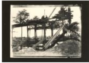
Brug leggen over het kanaal (Foto 03241_01 t.e.m. 03241_03)
