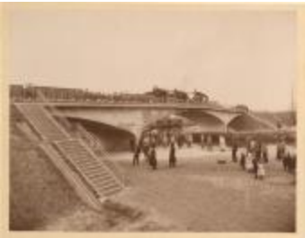
Brug over kanaal / belastingsproef (Foto 02180_01; 02180_02; 02180_03)
