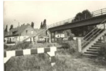
Voetgangers/fietsbrug over de Vaart (Foto 00672_01; 05222_01)
