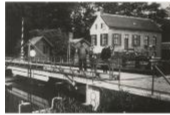
Brugwachtershuis aan brug 8 (Meirgoren) (Foto 05825_01)
