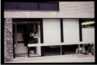
Tandtechnisch Labo (container 33_1330)
