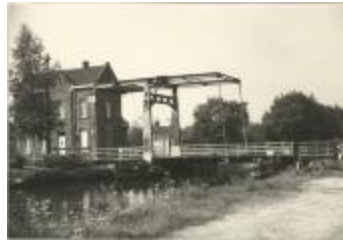
Brug 1 over de Vaart (Foto 00672_02)
