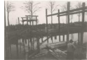
Bouwen van een kanaalbrug (Foto 05476_01; 05476_02)
