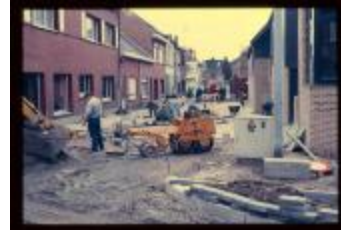
Heraanleg (Dia container 61_B34)
