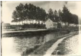
Brug 1 over het kanaal (Foto 01507-01)
