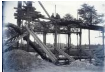
Bouwen van een brug (Glas_04_84)
