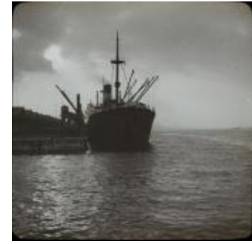
Aan Noordersluis P.V.Hal 1923 (Glas1990)
