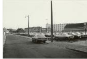
parking Muylenberg (Foto 07036-05)
