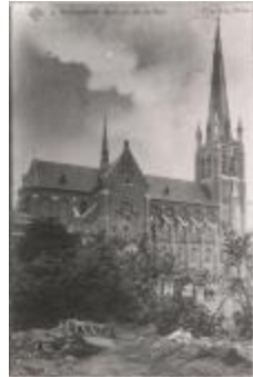
Opbouw H. Hartkerk (Foto 06442-02)
