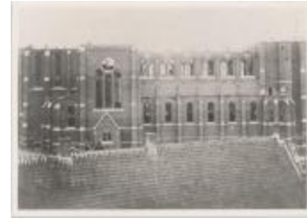
Opbouw H. Hartkerk (Foto 06442-04)
