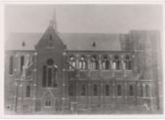
Opbouw H. Hartkerk (Foto 06442-01)
