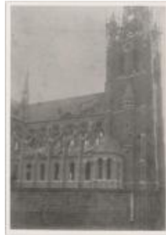
Opbouw H. Hartkerk (Foto 06442-03)
