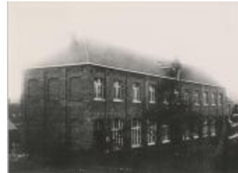
Kantschool Klinkstraat / gebouwen (Foto 05905_01; 05905_02; 05903_03; 05905_05)
