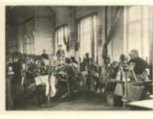
Kantschool / interieur (Foto 04161_01 en 04161_02)
