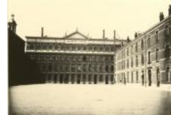
St. Jozefscollege / binnenplaats (Foto 04622_01; 04622_02)
