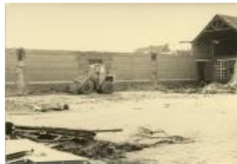
School Levensvreugde Schoolstraat / afbraak (Foto 04740_01; 04740_02 en 04740_04 t.e.m. 04740_09)
