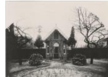
Kantschool Klinkstraat / gebouwen (Foto 05905_04)
