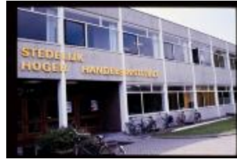
Voorgevel (Dia container 53_09)
