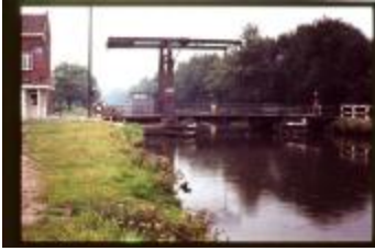
Brug I (Dia container 1_5)
