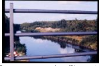
Fiets- en voetgangersbrug (Dia container 3_14)
