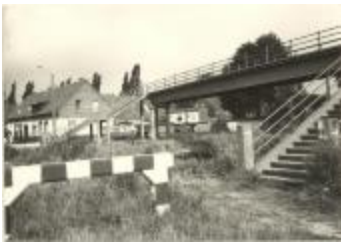
Voetgangers/fietsbrug over de Vaart (Foto 00672_01; 05222_01)
