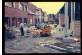
Heraanleg (Dia container 61_B34)
