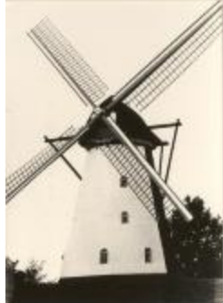
Stenen windmolen op Ter Loo: na restauratie (Foto 03264_01 en 03264_02)
