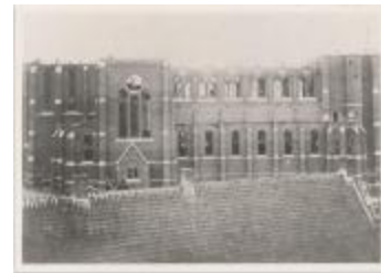
Opbouw H. Hartker (Foto 06442-04)
