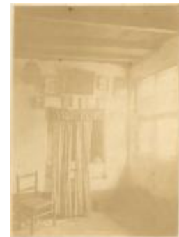
Hoeve (interieur) / alkoof (Sluis) (Foto 03108_01)
