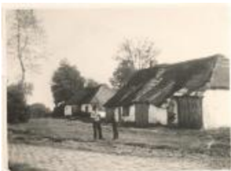
Hoeve met schuur (leem wanden en strooien dak) : (Foto 01227-01 en 02)
