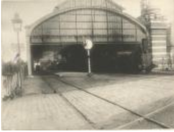
Station / zicht op sporen en glazen koepel en stoomtrein (Foto 00691-01)
