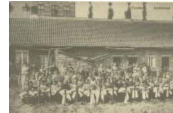
Kantschool in de Tien Geboden (Apostoliekschool) (Foto 04837_01)
