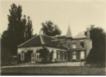
Buitengoed "Boone's Blijk" / achterkant / Heizijde (Foto 04579_01)
