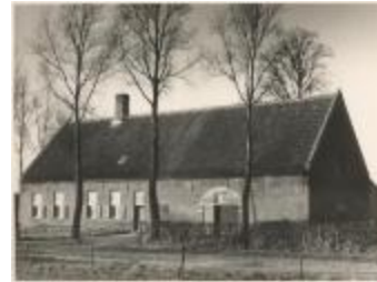
Gasthuishoeve - Hoeve Godshuizen / Heizijde (Foto 00406_01 tem_03)
