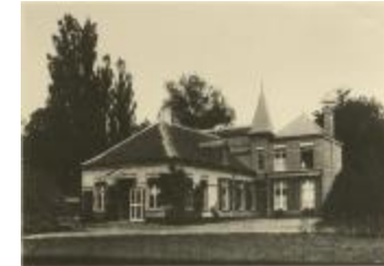
Buitengoed "Boone's Blijk" / achterkant / Heizijde (Foto 04579_01)
