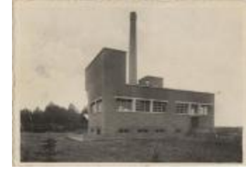
St. Jozef-College te Turnhout Stoom- en electriciteitcentrale. (Prentbriefkaart 32_029)
