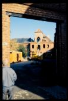
Verbouwingwerken (Dia container 5_2487)
