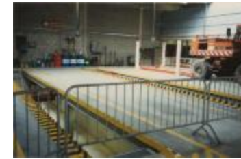
Het nieuwe stadsmagazijn in Everdongenlaan / interieur (Foto 06551-07)
