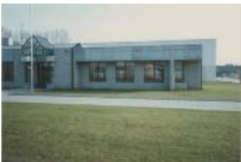
Het nieuwe stadsmagazijn in Everdongenlaan / exterieur (Foto 06550-05)
