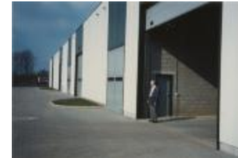
Het nieuwe stadsmagazijn in Everdongenlaan / exterieur (Foto 06550-04)
