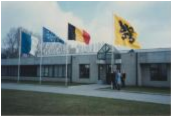
Het nieuwe stadsmagazijn in Everdongenlaan / exterieur (Foto 06550-09)
