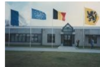
Het nieuwe stadsmagazijn in Everdongenlaan / exterieur (Foto 06550-08)
