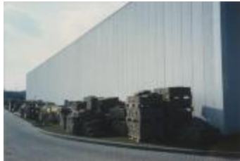
Het nieuwe stadsmagazijn in Everdongenlaan / exterieur (Foto 06550-02)
