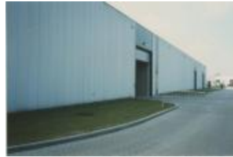
Het nieuwe stadsmagazijn in Everdongenlaan / exterieur (Foto 06550-03)
