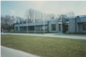
Het nieuwe stadsmagazijn in Everdongenlaan / exterieur (Foto 06550-01)
