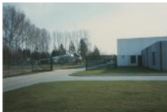
Het nieuwe stadsmagazijn in Everdongenlaan / exterieur (Foto 06550-06)
