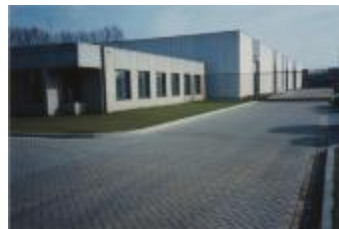
Het nieuwe stadsmagazijn in Everdongenlaan / exterieur (Foto 06550-07)
