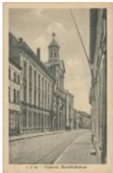
Turnhout, Herenthalsstraat Turnhout - Entrée du Béguinage (Prentbriefkaart 29_038)
