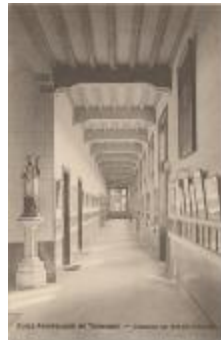
Ecole Apostolique de Turnhout. - Corridor du rez-de-chaussée. (Prentbriefkaart 33_036)
