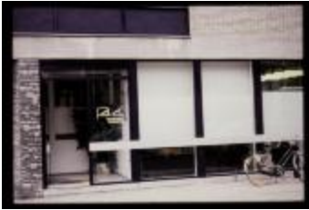
Tandtechnisch Labo (container 33_1330)
