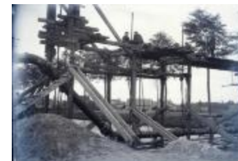
Bouwen van een brug (Glas_04_84)
