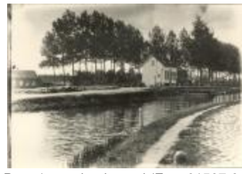
Brug 1 over het kanaal (Foto 01507-01)
