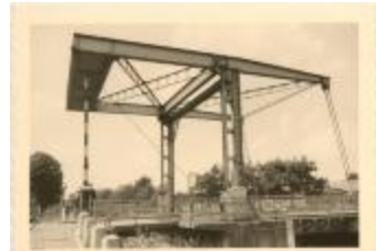
Brug 2 over het kanaal (Foto 00201_01; 00201_02)
