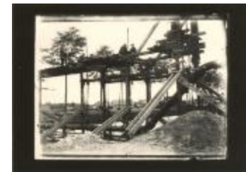
Brug leggen over het kanaal (Foto 03241_01 t.e.m. 03241_03)
