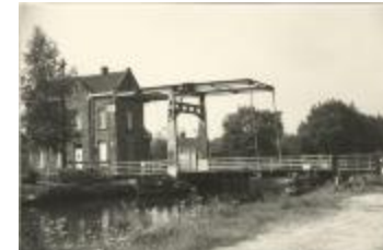
Brug 1 over de Vaart (Foto 00672_02)
