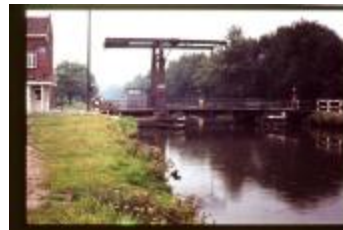
Brug I (Dia container 1_5)
