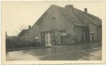
Hoeve "de Diepe" (woning Klein Peerken) / interieur + exterieur (Foto 04735b_01 t.e.m. 04735b_04)
