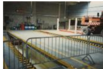
Het nieuwe stadsmagazijn in Everdongenlaan / interieur (Foto 06551-07)
