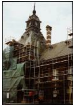
Renovatie stationsgebouw (INSPRAAK_0138)
