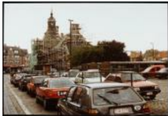
Renovatie stationsgebouw Turnhout (INSPRAAK_0137)
