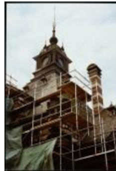
Renovatie stationsgebouw (INSPRAAK_0139)
