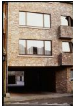
Gevel van appartement in Korte Gasthuisstraat (INSBRAAK_0130)
