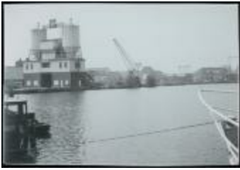
Nieuwe Kaai met cementfabriek (INSPRAAK_0083)
