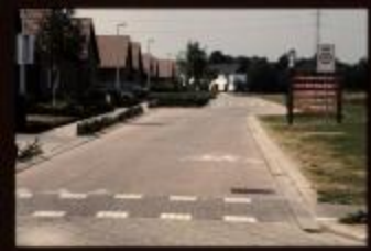
Zicht vanuit de Steenweg op Tielen op de Jef Buyckxstraat te Turnhout. (container 35_2510)
