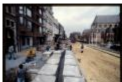
Heraanleg (Dia container 38_3435)
