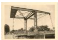
Brug 2 over het kanaal (Foto 00201_01; 00201_02)
