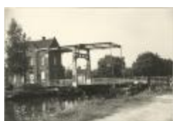
Brug 1 over de Vaart (Foto 00672_02)
