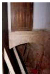
Kasteel van de Hertogen van Brabant. Kelderverdieping. (Foto 09976)
