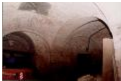
Kasteel van de Hertogen van Brabant. Kelderverdieping. (Foto 09973)
