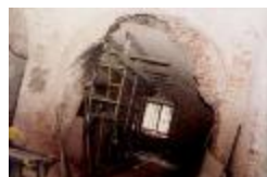
Kasteel van de Hertogen van Brabant. Kelderverdieping. (Foto 09979)
