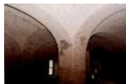
Kasteel van de Hertogen van Brabant. Kelderverdieping. (Foto 09977)
