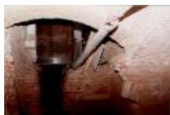
Kasteel van de Hertogen van Brabant. Kelderverdieping. (Foto 09982)
