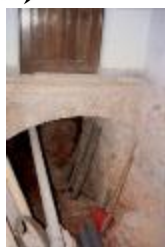
Kasteel van de Hertogen van Brabant. Kelderverdieping. (Foto 09975)
