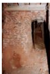
Kasteel van de Hertogen van Brabant. Kelderverdieping. (Foto 09980)
