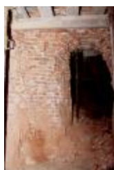
Kasteel van de Hertogen van Brabant. Kelderverdieping. (Foto 09981)
