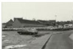
Parking Muylenberg (Foto 07036-10)
