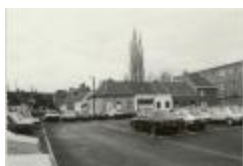
parking Muylenberg (Foto 07036-07)
