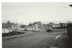
Parking Muylenberg (Foto 07036-09)
